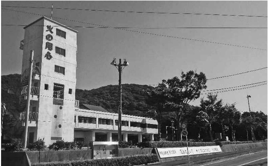
ア：左手前には消防署の訓練棟、奥には庁舎が見えます。 くんれんどう
